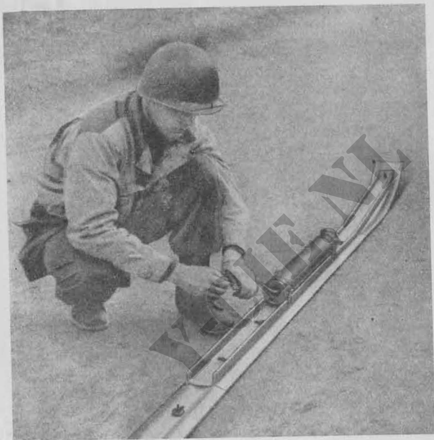
Figuur 44. Het bevestigen van de vuurkoordontsteker aan het vuurkoord.
