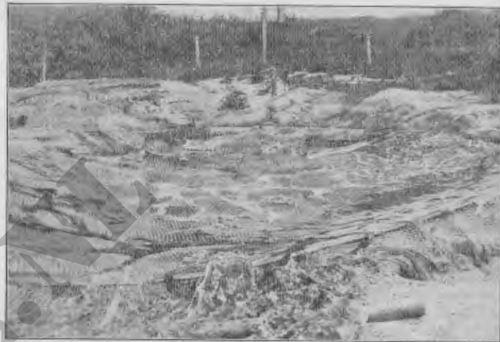
Fig. 55b. Maskeeringsschermen over eenige groote granaatrechters, verbonden door kruipgeulen.
