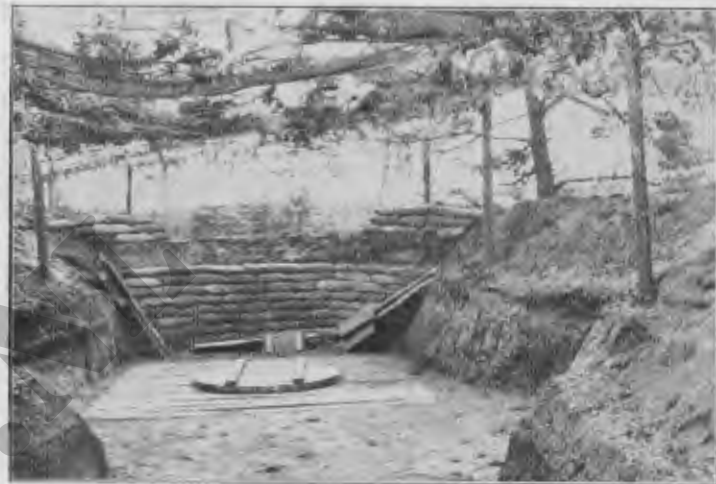
Fig. 72b. Gemaskeerde bouw van een geschutopstelling volgens fig. 72a.
