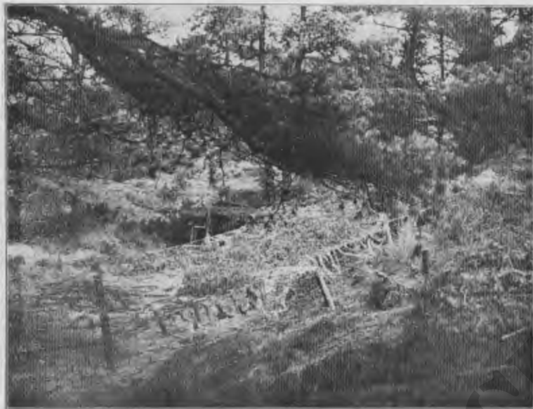
Fig. 63c. Gemaskeerde bouw van een groep scherfvrije schuilplaatsen voor een commandopost in een onduidelijk bos.
