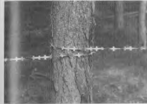
Figuur 29 Het vastzetten van het getordeerde prikkelband met één slag om een van de tussengelegen steunpunten.
