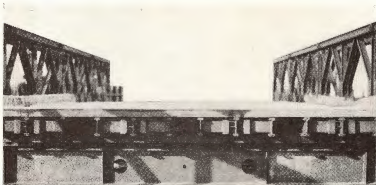
fig. 69 een plank wordt tijdelijk op de eerste dwarsligger geplaatst
