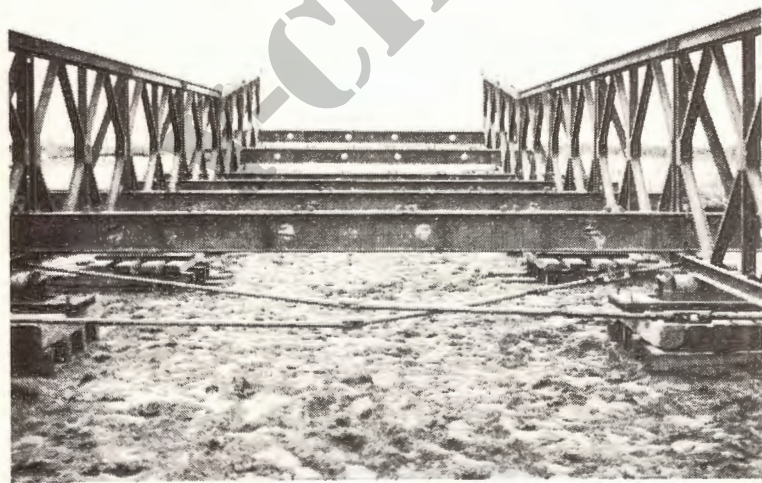
fig. 64 de neus gezien over de brugas
