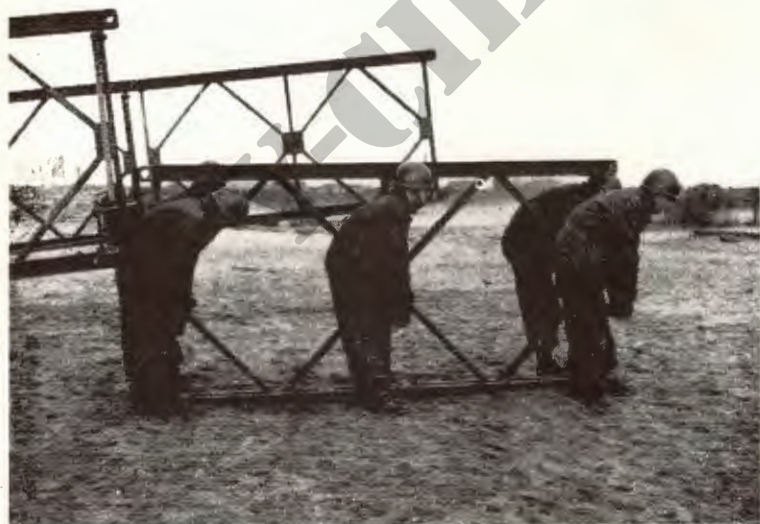
fig. 74 de neus wordt afgebroken
