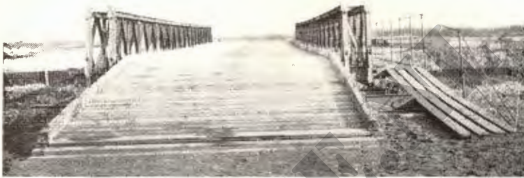
fig. 83 de uit twee delen bestaande oprit is voltooid
